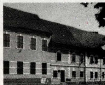
Obnovená historická budova Literárneho a hudobného múzea v Banskej Bystrici.
