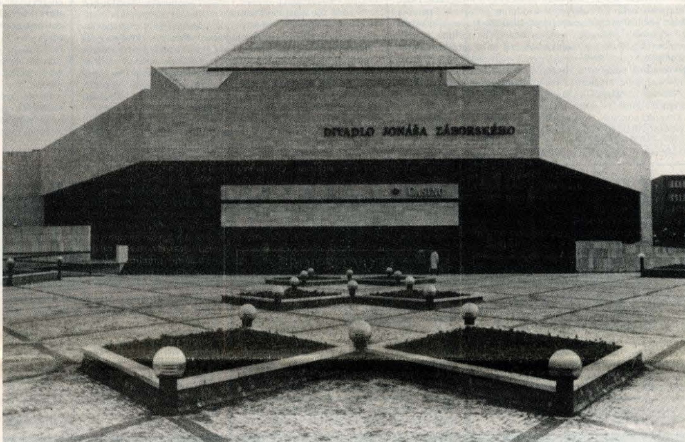
Divadlo Jonáša Záborského v Prešove svoje päťdesiatiny oslávilo v novej budove, odovzdanej do užívania v roku 1990. Je to vôbec prvá divadelná budova postavená na Slovensku od r. 1945.
