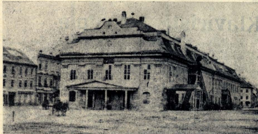
Budova starého divadla — na mieste dnešného SND (so záchrannými schodami).
